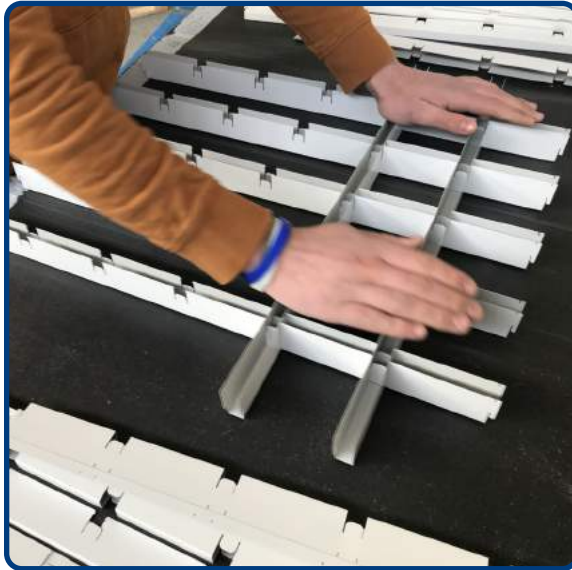
Inserire listelli Tipo A Maschio Insert the blade Type A Male
